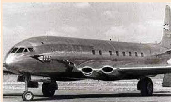
Se suspenden los vuelos y tras exhaustivas investigaciones se descubre que al ser las ventanillas cuadradas, el aluminio se fisuraba en las esquinas por “fatiga” de material, luego se agrietaba y finalmente se abría catastróficamente. A partir de
